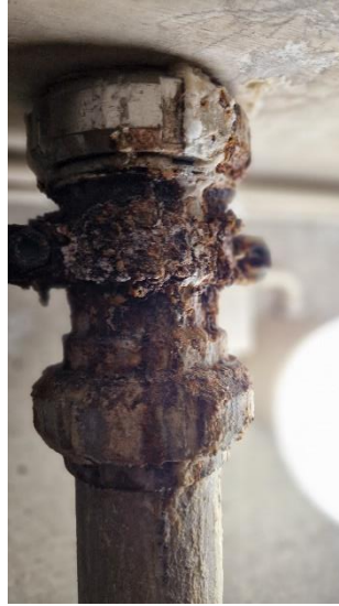
Bild 45 - Exempel på kraftigt korroderad rörledning till bassäng.
