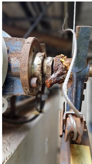
Bild 51 - Korroderade rörinstallationer.
