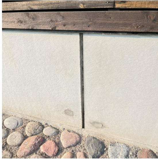
Bild 34 - Bild på avsaknad av fog samt delagningar.
