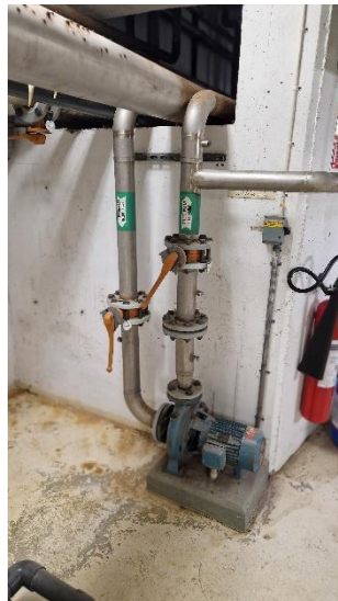
Bild 47 - Exempel på äldre badvattenpump i dåligt skick.
