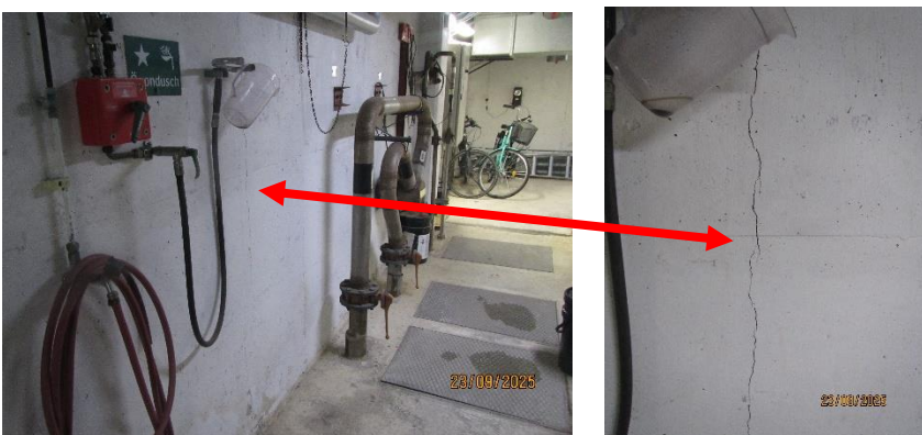
Foto 5. En av flera större sprickor som konstaterades på ytterväggen runt simbassängen (dvs inte bassängkonstruktionen). Denna spricka mättes till flera mm i sprickvidd (mellan 2-4 mm).
