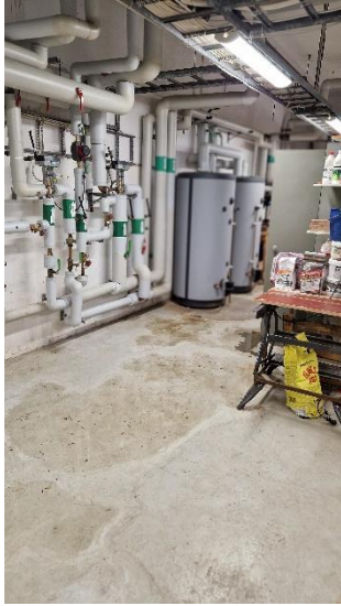
Bild 68 - Elvärmeberedare i UC. Stora vattenansamlingar på golvet, sannolikt kondensvatten från installationer.
