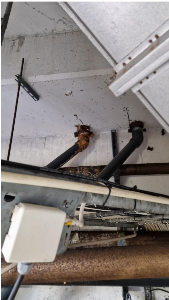
Bild 66 - Korroderade rörledningar.
