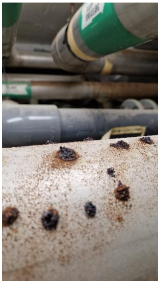
Bild 50 - Korroderade rörledningar.
