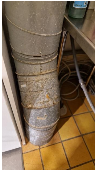
Bild 39 - Korroderad ventilationskanal i reception.
