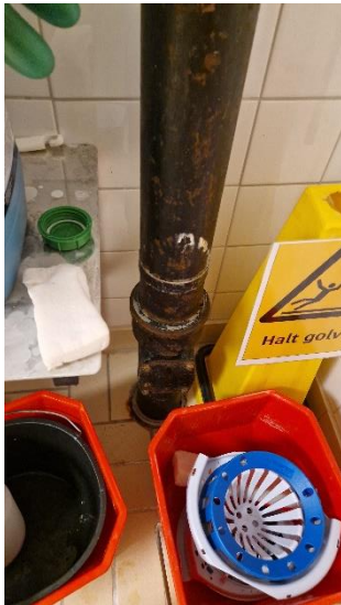
Bild 38 - Exempel på avloppsstam i slitet skick.
