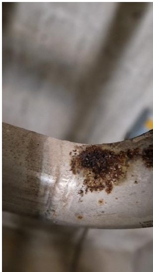
Bild 54 - Korroderade rörledningar.
