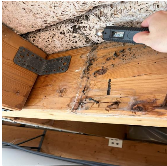
Bild 12 - Bild på indikation vid undertak/träullit (vid kiosken), värde lika referensvärdet (påvisar ej förhöjda värden).
