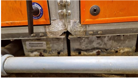
Bild 64 - Ventilationsaggregat i dåligt skick. Korrosionsskador finns. Aggregatet läcker kondensvatten på många ställen. Stora vattenansamlingar finns på golvet i fläktrummet.
