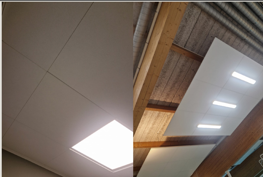
Nedpendlade undertak till vänster (dessa har dolt bärverk) 60 x 60, till höger större plattor och träullsplattor som sitter i simhallen.
