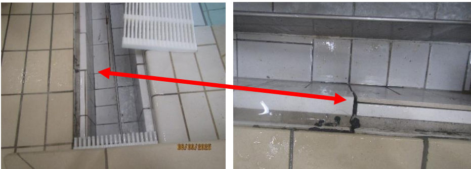
Foto 1. Skvalpränna med avskiljande rostfri plåt. Lokala brister återfanns på klinkerplattor.
