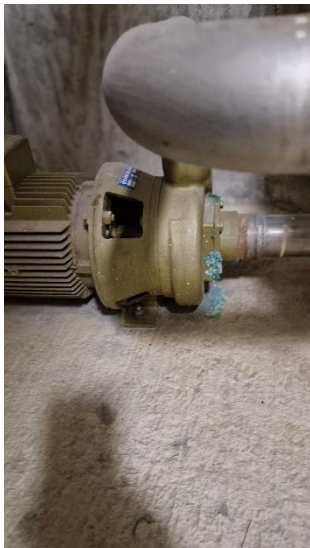
Bild 46 - Exempel på äldre badvattenpump i dåligt skick.
