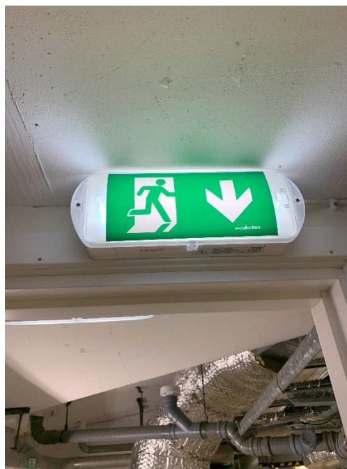
Foto 6. Moderna nödutrymningsskyltar som inte innehåller kadmiumbatterier.
