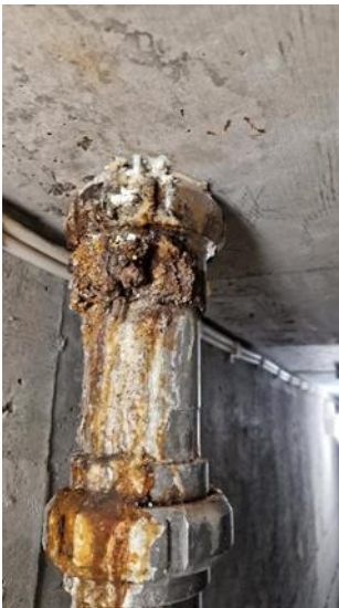
Exempel på kraftigt korroderad rörledning till bassäng.
