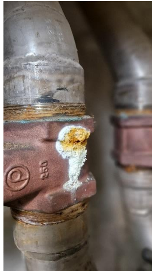
Bild 53 - Korroderade rörledningar.
