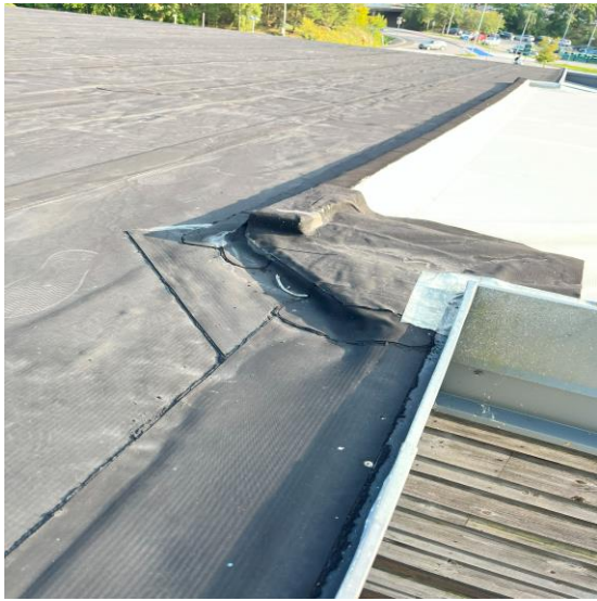
Bild 5 - Bild på del-lagning, riskfylld otät övergång mellan APP & PVC samt veck.
