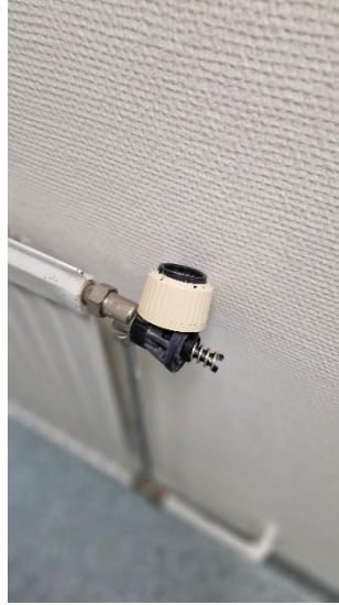
Bild 41 - Exempel på trasig termostatventil.
