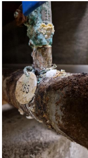
Bild 55 - Korroderade rörledningar.
