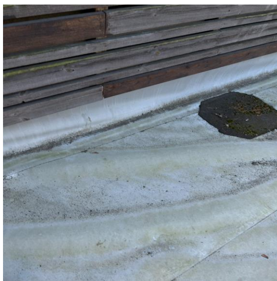
Bild 4 - Bild på del-lagning, veck-bildning och vegetation på yttertaket.
