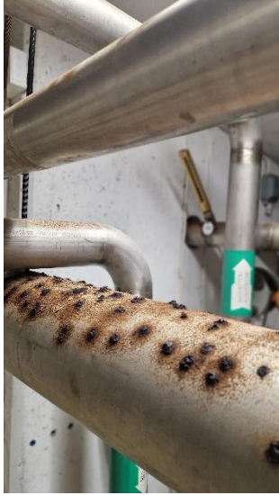
Bild 48 - Korroderade rörledningar.
