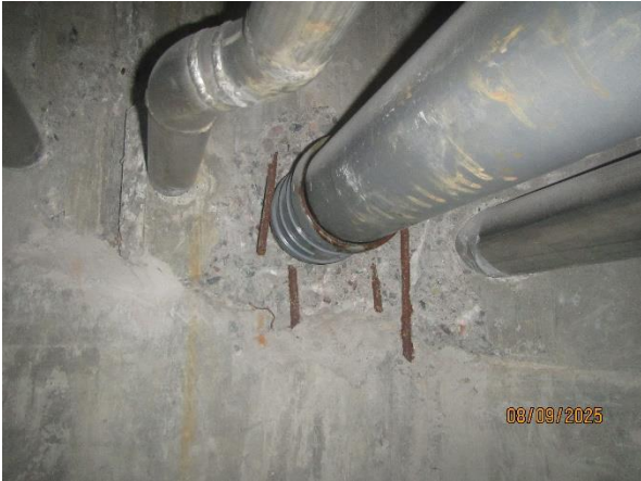
Foto 3. En genomföring i avskiljande vägg vid långsidan av simbassängen med armeringskorrosion. Dock ej väggkonstruktion för bassängerna.
