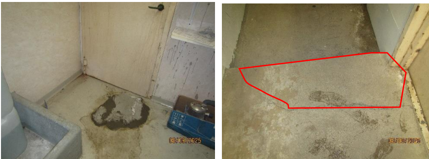
Foto 11. Område i anslutning till dörr vid kem-rummet. Bompartier (rödmarkerat område) och korrosionsskadad stäldörr.
