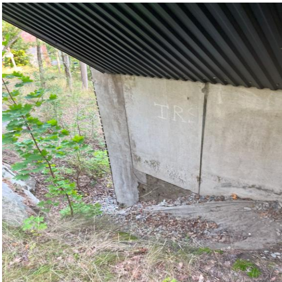
Bild 35 - Bild på avsaknad av platonmatta till skillnad från den östra sidan som hade delar av det. Även noterade skador på sockel/grundmur noterades.
