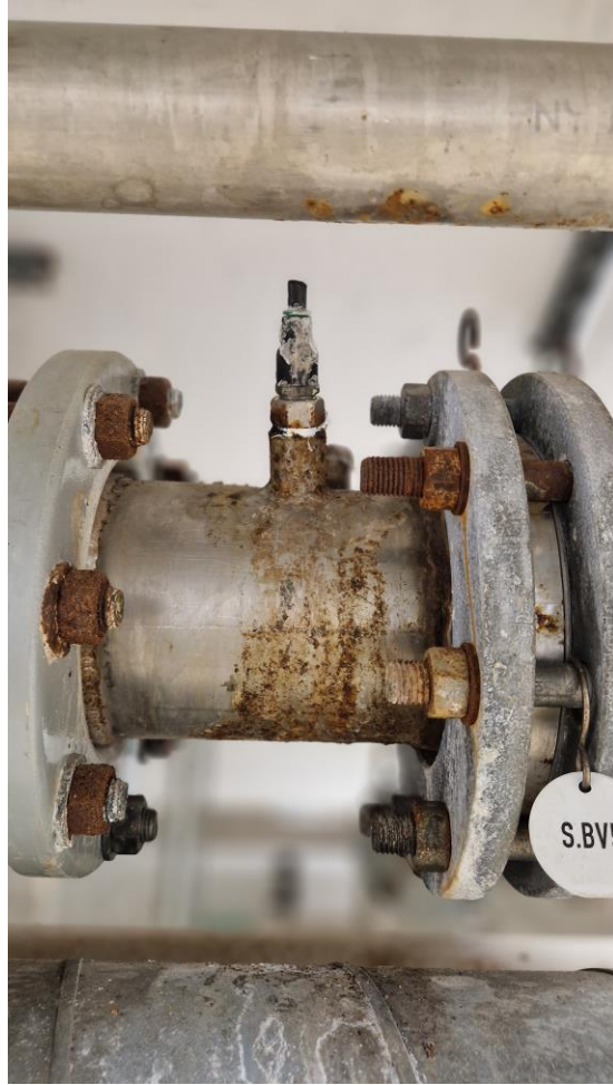
Bild 49 - Korroderade rörinstallationer.
