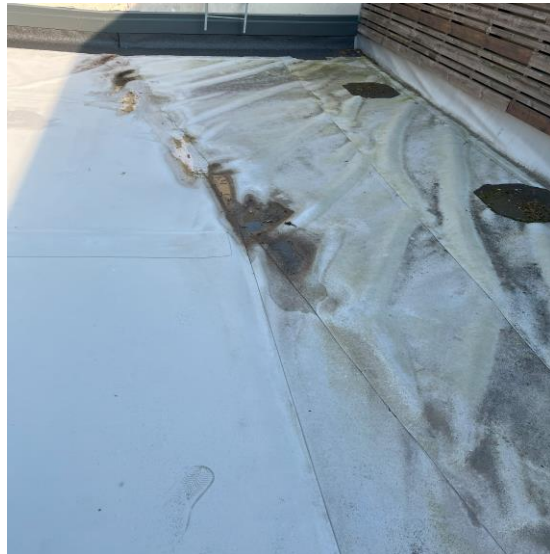
Bild 6 - Bild på brister i fall, veck & stående vatten.
