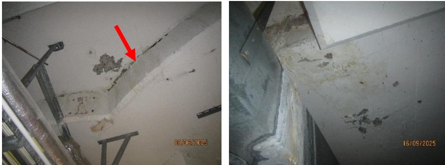
Foto 6. Rörelsefog mellan skvalpränna och bjälklag. Främst observerades rost- och kalkutfällningar samt några mindre aktiva läckage vid några områden runt bassängen.
