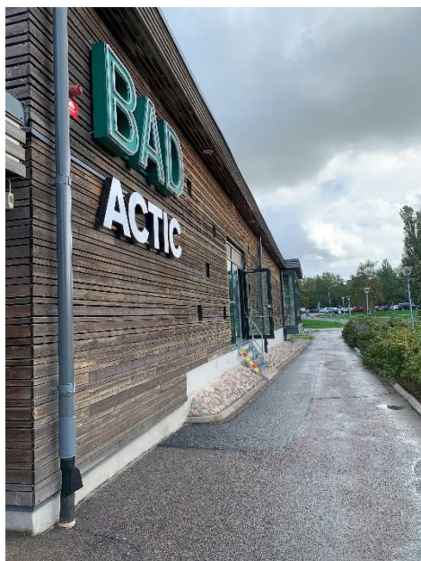
Foto 9. Utvändig fasadbeklädnad av träpanel.
