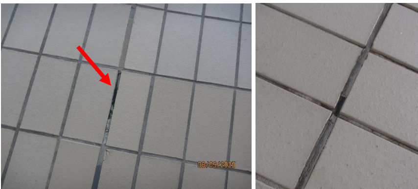
Foto 2. Bristfällig fogmassa vid rörelsefog, återfanns vid flera områden runt bassängen.
