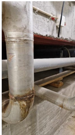
Bild 59 - Korroderade rörledningar. Ledningar är monterade/upphängda på träplankor vilka är rötskadade. Mycket olämplig lösning.
