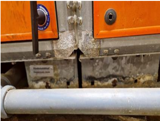
Bild som visar ett ventilationsaggregat i dåligt skick. Korrosionsskador finns. Aggregatet läcker kondensvatten på många ställen. Stora vattenansamlingar finns på golvet i fläktrummet.
