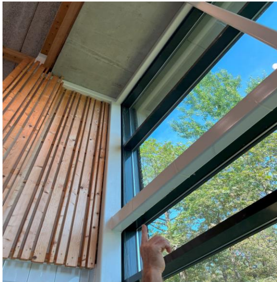
Bild 21 - Bild på missfärgningar från tidigare läckage.
