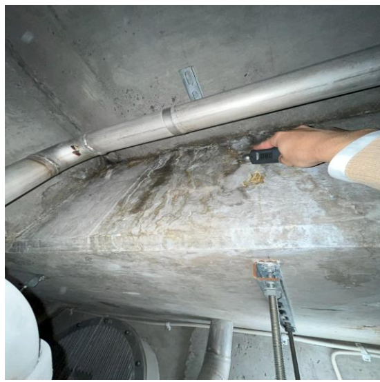
Bild 32 - Bild som visar på fukt från simhallsdelen i källarplan (högre värde än referensvärdet).
