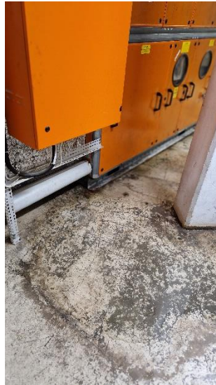
Bild 61 - Ventilationsaggregat samt vattenansamling på golv.
