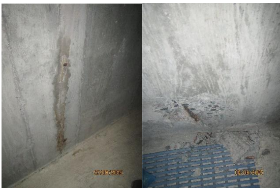
Foto 4. Mindre betongskador konstaterades i anslutning till källargolvet men avsåg främst anslutande väggar och inte simbassängens konstruktion.
