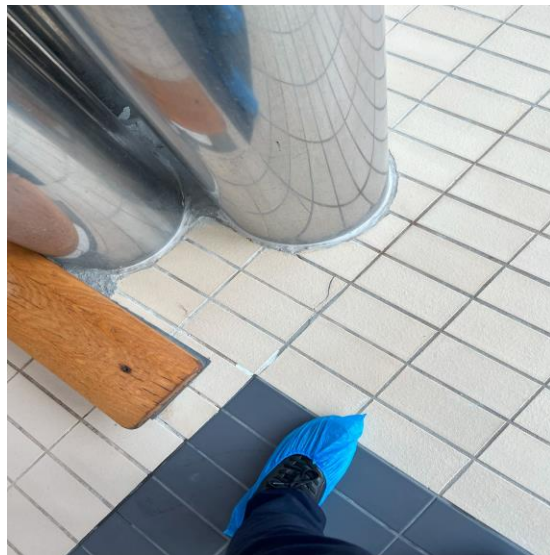
Bild 28 - Bild på sprickor på klinker.
