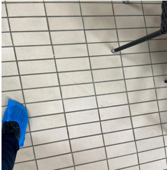
Bild 25 - Bild på sprickor på klinker.
