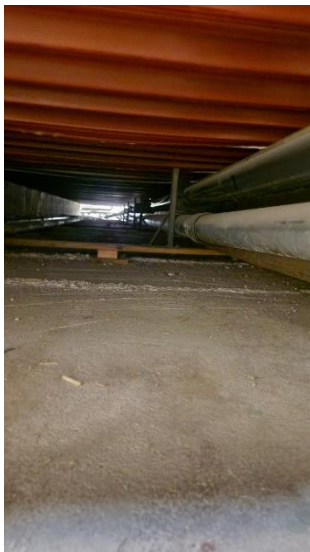
Bild 58 - Korroderade rörledningar. Ledningar är monterade/upphängda på träplankor vilka är rötskadade. Mycket olämplig lösning.
