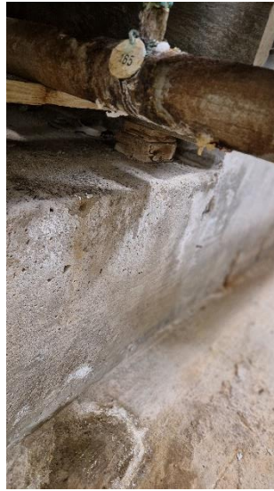
Bild 57 - Korroderade rörledningar. Ledningar är monterade/upphängda på träplankor vilka är rötskadade.
