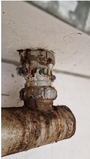
Bild 52 - Korroderade rörledningar.
