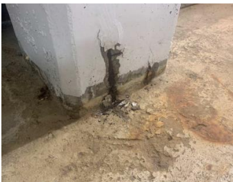
Foto 13. Pelare i fläktrummet med armeringskorrosion samt dåligt täckande betongskikt på armeringsjärnet.
