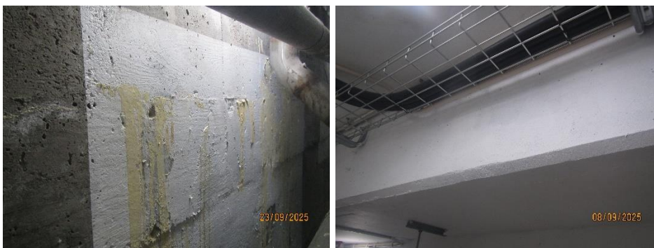
Foto 8. Exempel på områden som åtgärdats runt simbassängen. Det avsåg tätande injektering såväl som betongreparationer.
