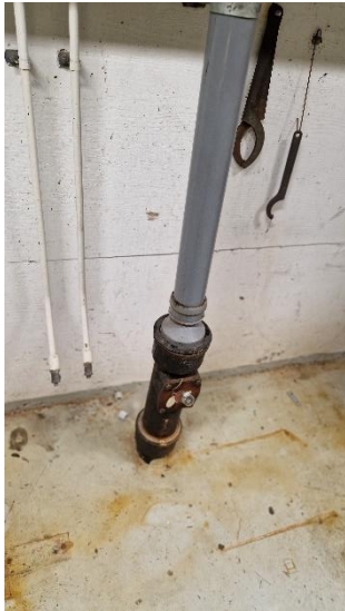
Bild 70 - Spillvattenstam med utvändigt korrosion.
