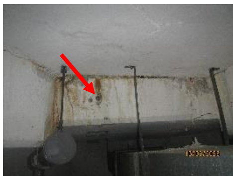
Foto 15. Exempel på läge för kloridprovtagning på skvalprännan, mät punkt R1 (foto till höger) och R3 (foto till vänster)
