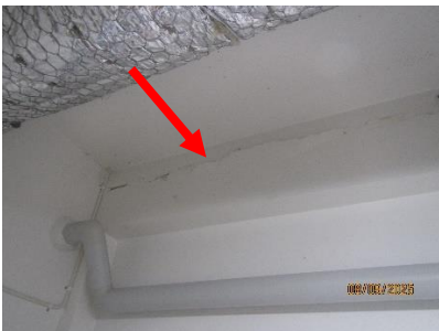
Foto 14. Spricka i tvätt-stuga där ytskikt demonterades lokalt för kontroll (där något mellanlägg av cellplast konstaterades).
