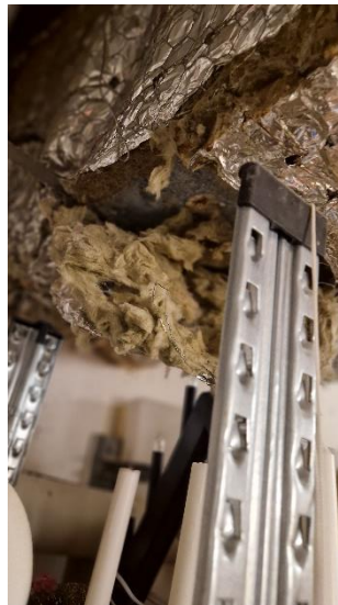
Bild 43 - Exempel på korroderad ventilationskanal i källaren med trasig isolering.
