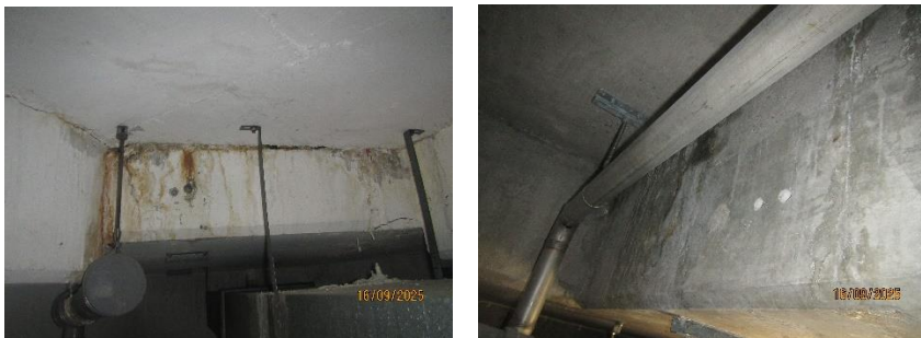
Foto 7. Ytterligare några områden med indikation på läckage ifrån rörelsefog.
