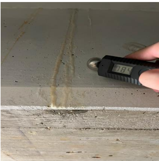
Bild som visar på aktivt läckage från simhallsdelen i källarplan
