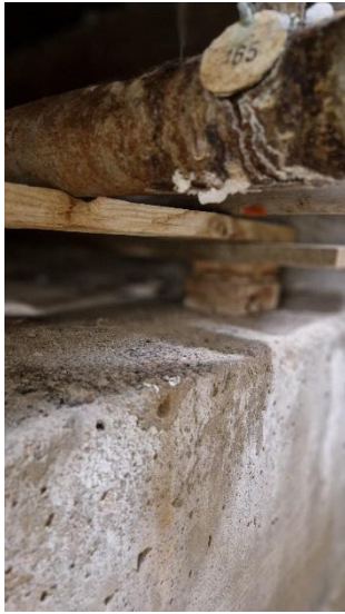
Bild 56 - Korroderade rörledningar. Ledningar är monterade/upphängda på träplankor vilka är rötskadade.
