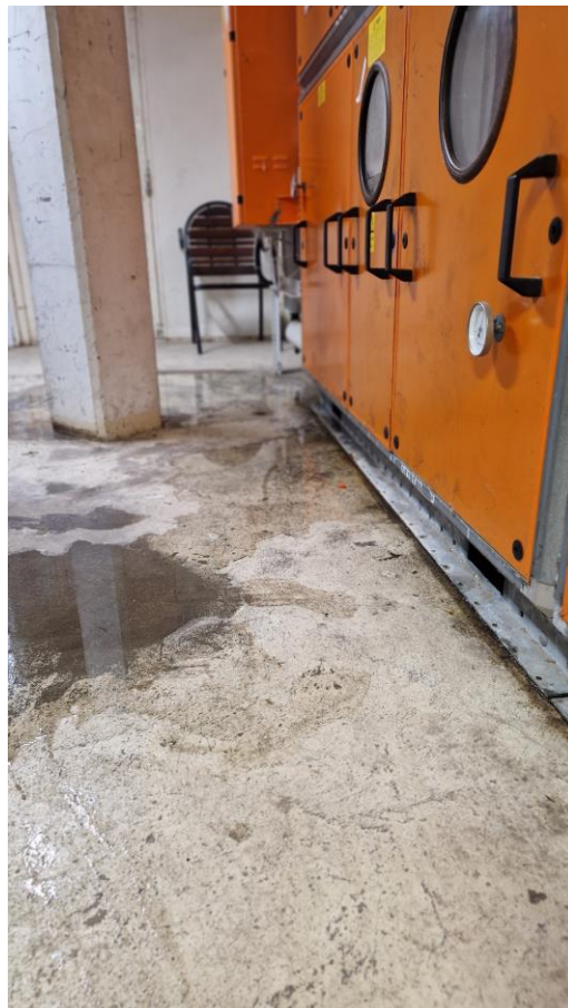
Bild 67 - Ventilationsaggregat i dåligt skick. Korrosionsskador finns. Aggregatet läcker kondensvatten på många ställen. Stora vattenansamlingar finns på golvet i fläktrummet.
