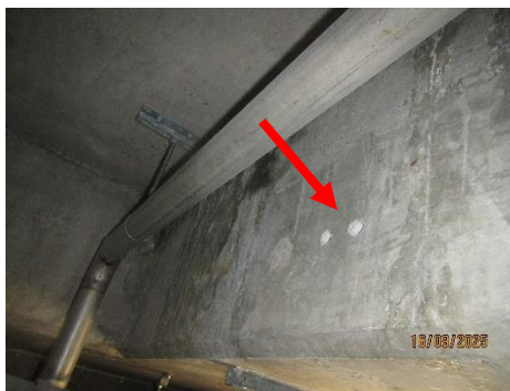
Foto 15. Exempel på läge för kloridprovtagning på skvalprännan, mät punkt R1 (foto till höger) och R3 (foto till vänster)
