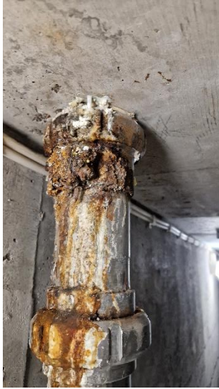
Bild 44 - Exempel på kraftigt korroderad rörledning till bassäng.
