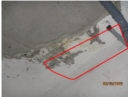
Foto 12. Igtutning av tidigare bubbelpool, foto taget ifrån källarplan. Runtomkring denna gjutning konstaterades flertalet betongspjälkningar och armeringskorrosion.
