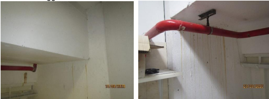
Foto 10. Bortre kortsidans ände med fuktutslag på vägg och ett antal mindre betongskador med armeringskorrosion. I det hörnet förekom även en mindre vattenansamling (läckage ifrån rörinstallation och eller vägg?).
