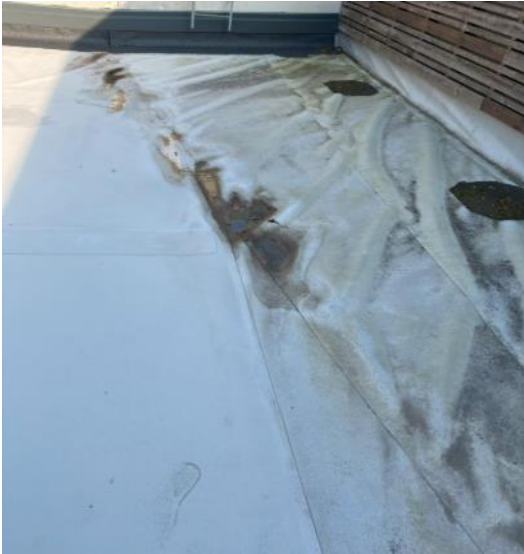
Bild på brister i fall, veck & stående vatten.
