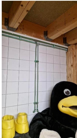
Bild 37 - Exempel på kraftigt ärgade ledningar och proppade tappvattenledningar med dödvatten.
