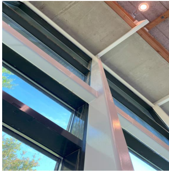
Bild 22 - Bild på missfärgningar från tidigare läckage.
