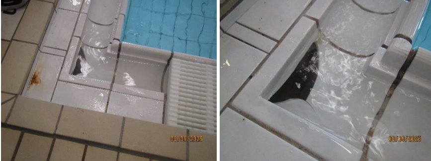
Foto 9. Exempel på skadad klinkerplatta vid hörnanslutning av skvalprännan.
