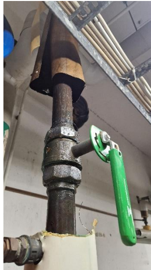
Bild 71 - Exempel på bristfällig rörisolering. Isoleringen är generellt blöt av kondens på många ställen.
