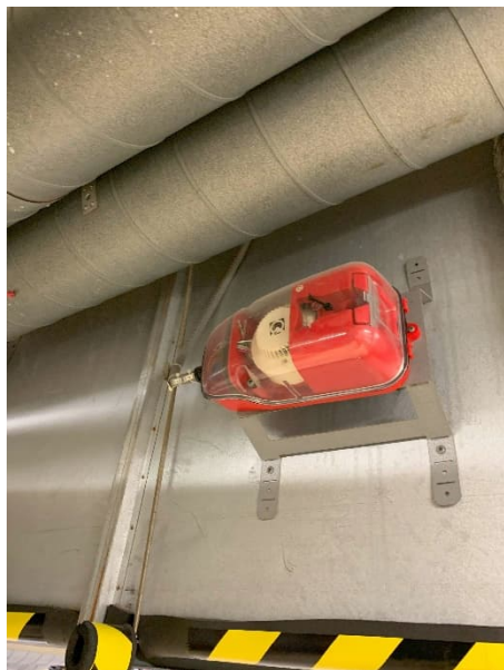
Foto 1. Joniserande rökdetektor kopplat till ventilationskanaler.
