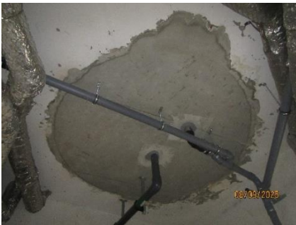
Foto 12. Igtutning av tidigare bubbelpool, foto taget ifrån källarplan. Runtomkring denna gjutning konstaterades flertalet betongspjälkningar och armeringskorrosion.
