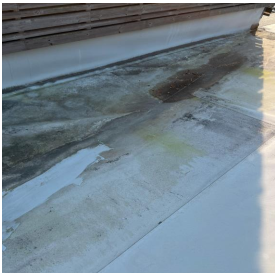
Bild 7 - Bild på del-lagning, brister i fall & stående vatten.
